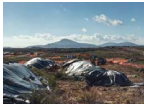
Bonifica terreno con cemento-amianto, Porto Torres (SO)
