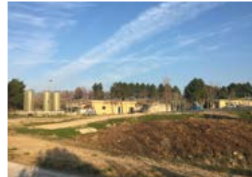
Impianto trattamento percolato di discarica, Senigallia (AN)
