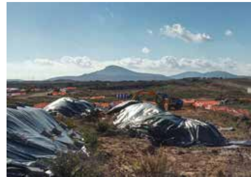
Bonifica terreno con cemento-amianto, Porto Torres (SO)
