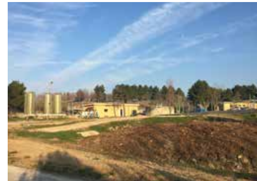
Impianto trattamento percolato di discarica, Senigallia (AN)
